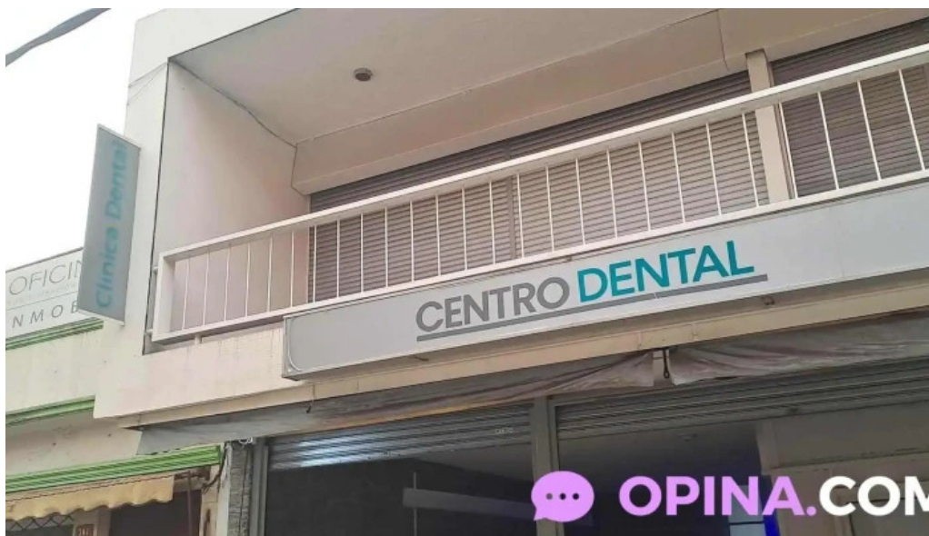
Oficina sosa exterior
