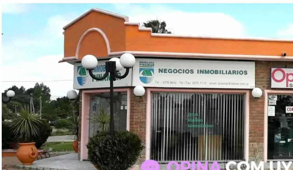
Inmobiliaria pinamar exterior
