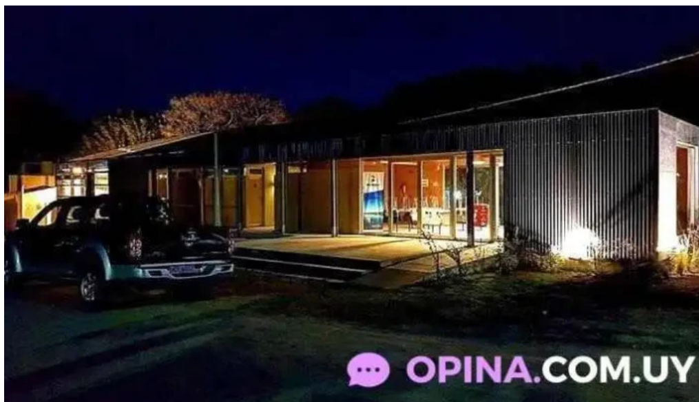
Estacion fluvial nuevo berlin exterior
