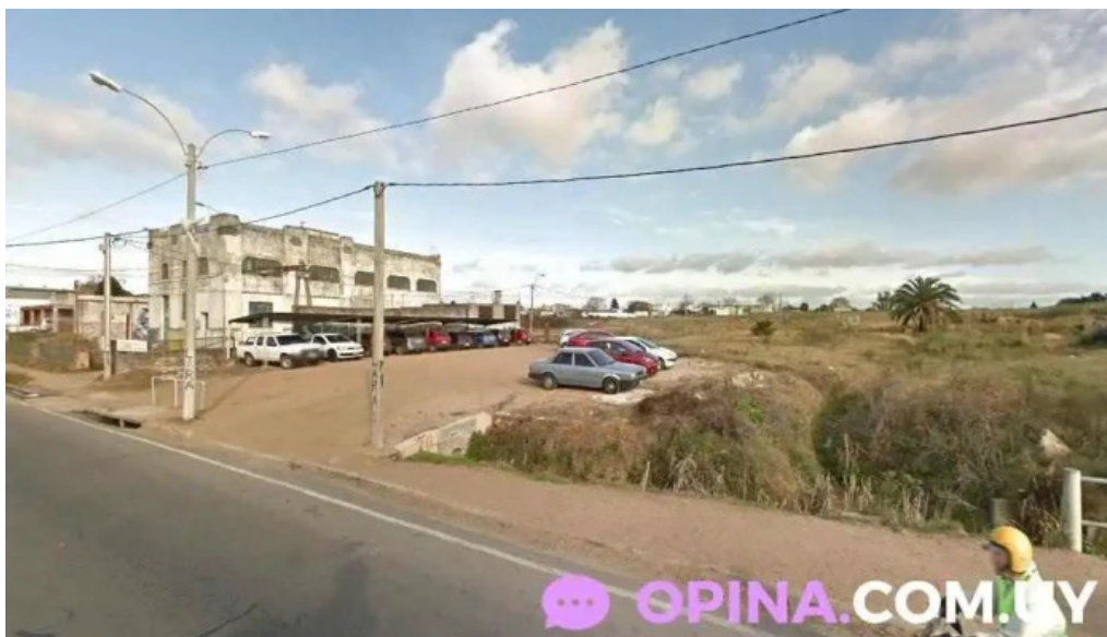
Centro de rehabilitacion del sur las piedras
