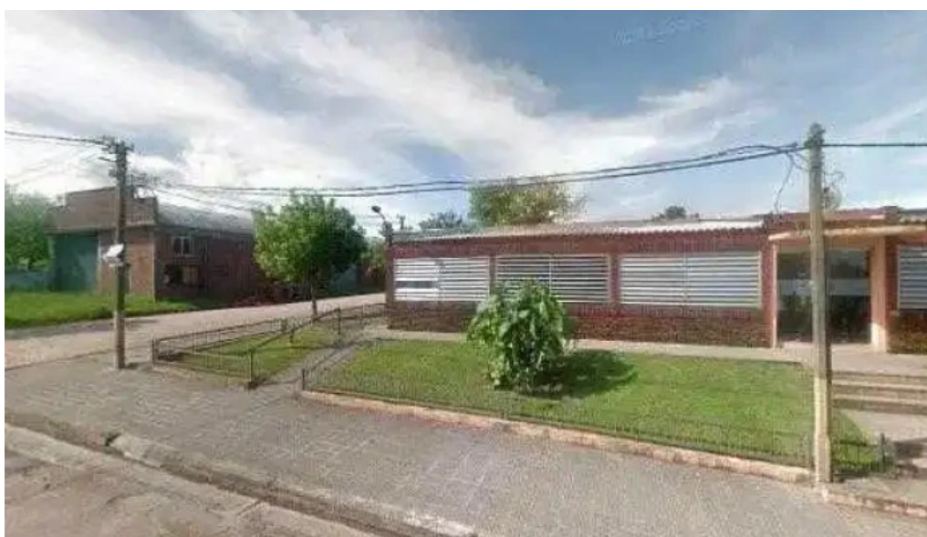
Centro auxiliar de vergara precios
