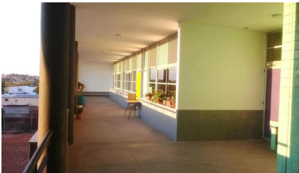
Escuela ndeg 39 edificio
