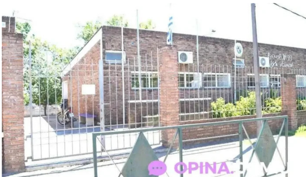
Escuela nº 99 grito de asencio mercedes
