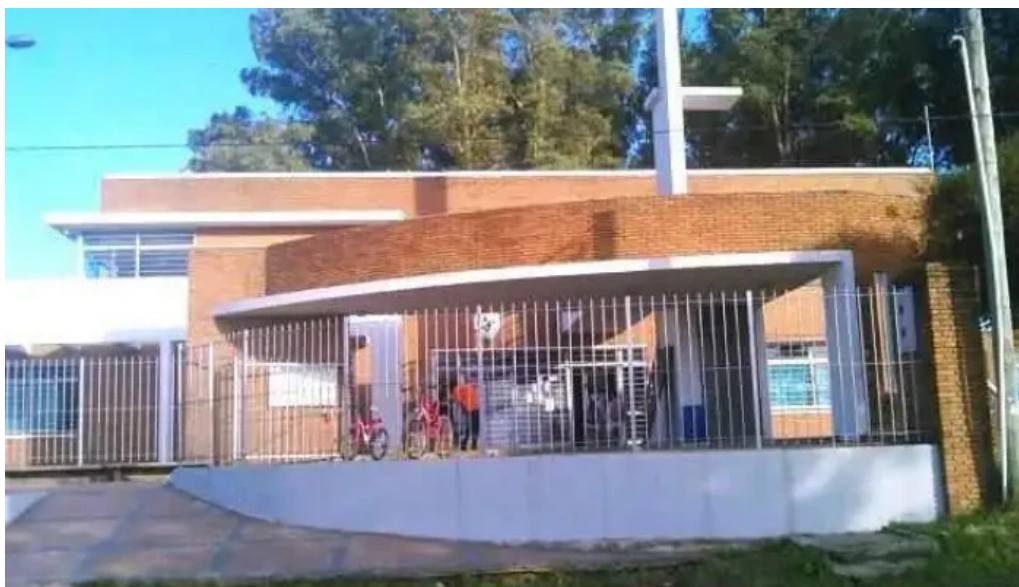
Escuela n 260 montes de solymar ciudad de la costa
