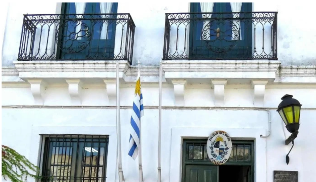
Escuela del hogar edificio
