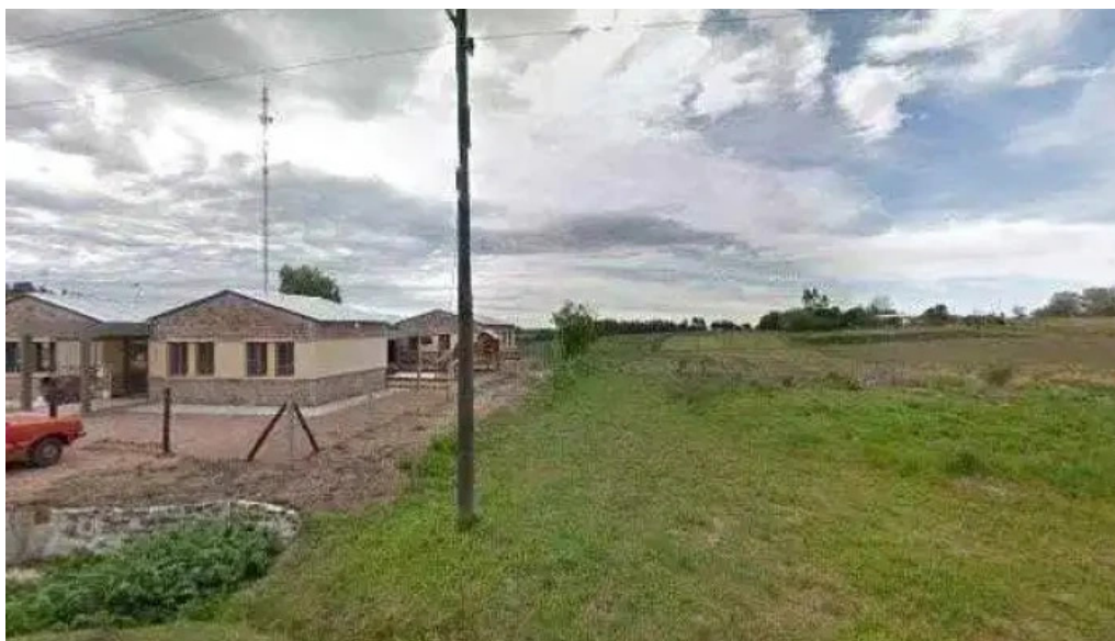
Caif los cerrillos fotos
