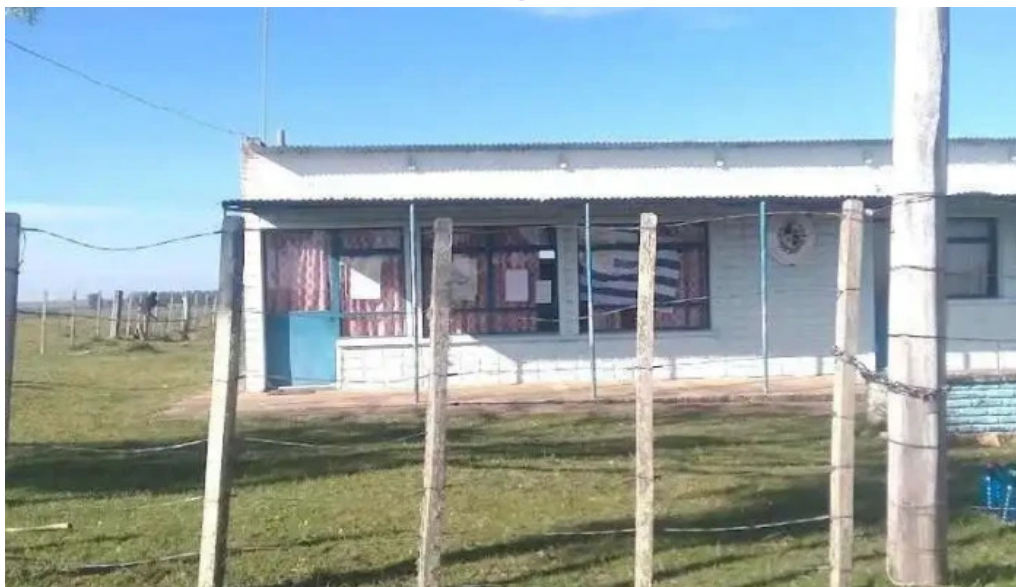
Escuela nº 15 coronilla de corrales minas de corrales
