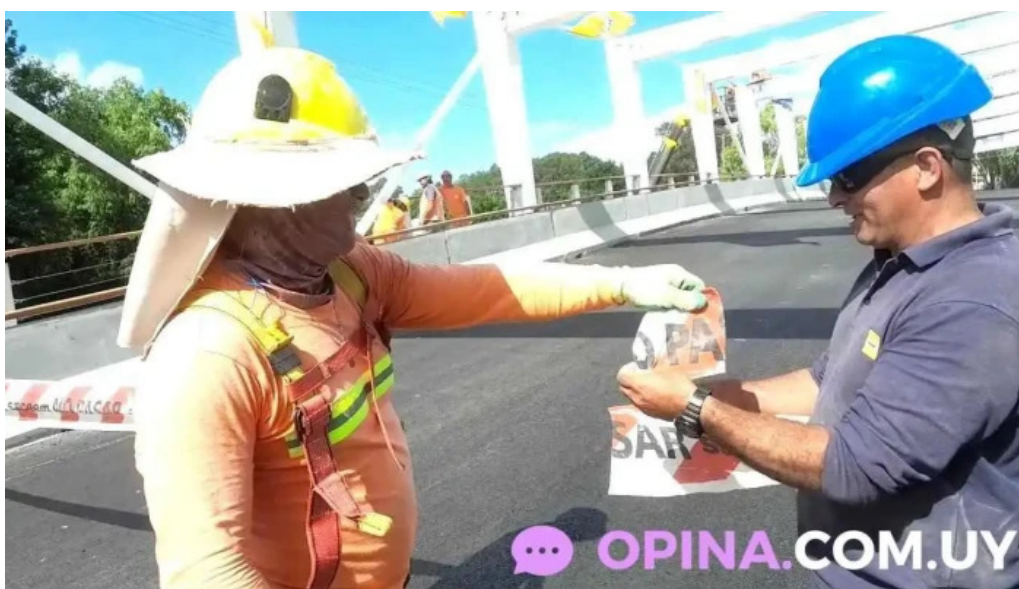
Puente paso real mas recientes
