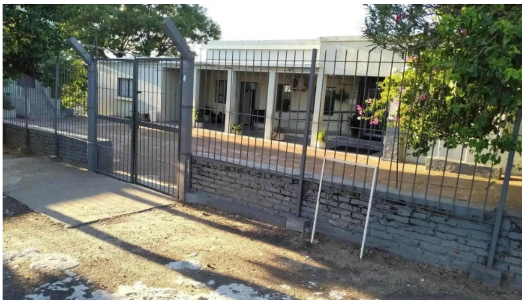
Escuela ndeg88 edificio
