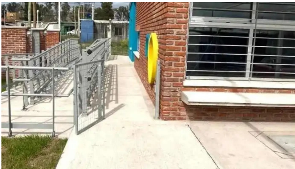
Caif el arca edificio
