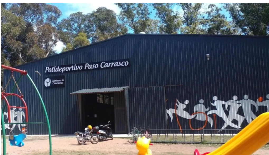
Polideportivo paso carrasco ciudad de la costa
