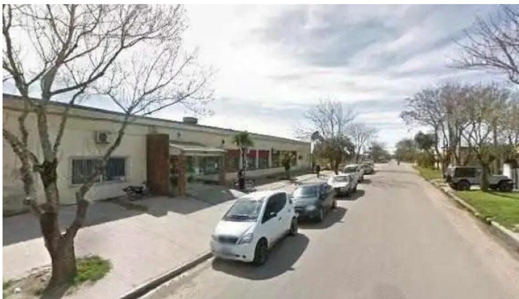
Centro auxiliar de chuy numerodeg
