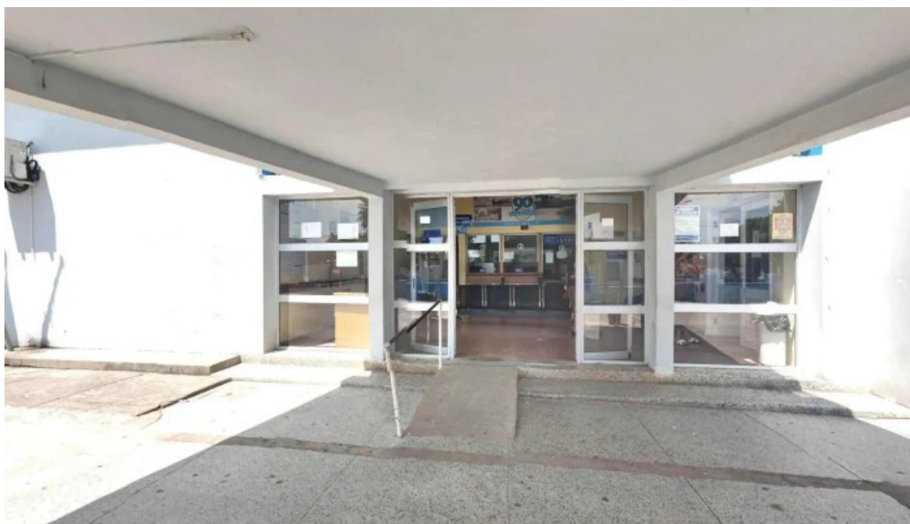
Hospital de treinta y tres edificio
