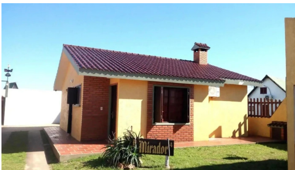
Casas del mirador exterior
