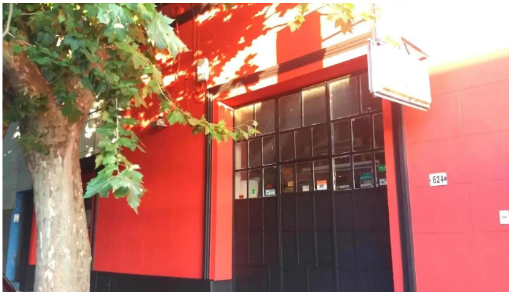
Imprenta minas exterior
