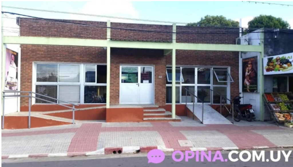
Fundacion san antonio de padua sitio web
