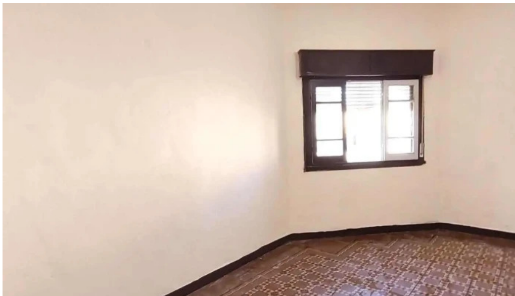
Del litoral mantenimiento interior
