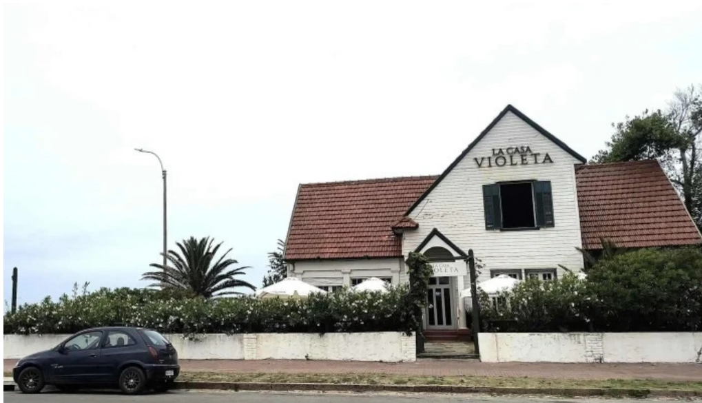
La casa violeta ubicacion
