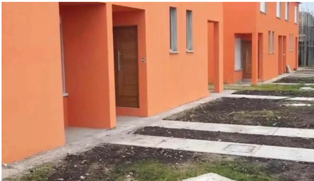
Cooperaiva arcoiris exterior
